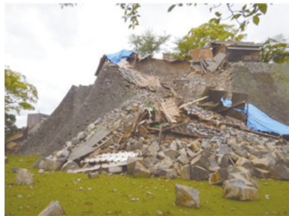
図-5 FK21（北十八間櫓）崩壊の様子
